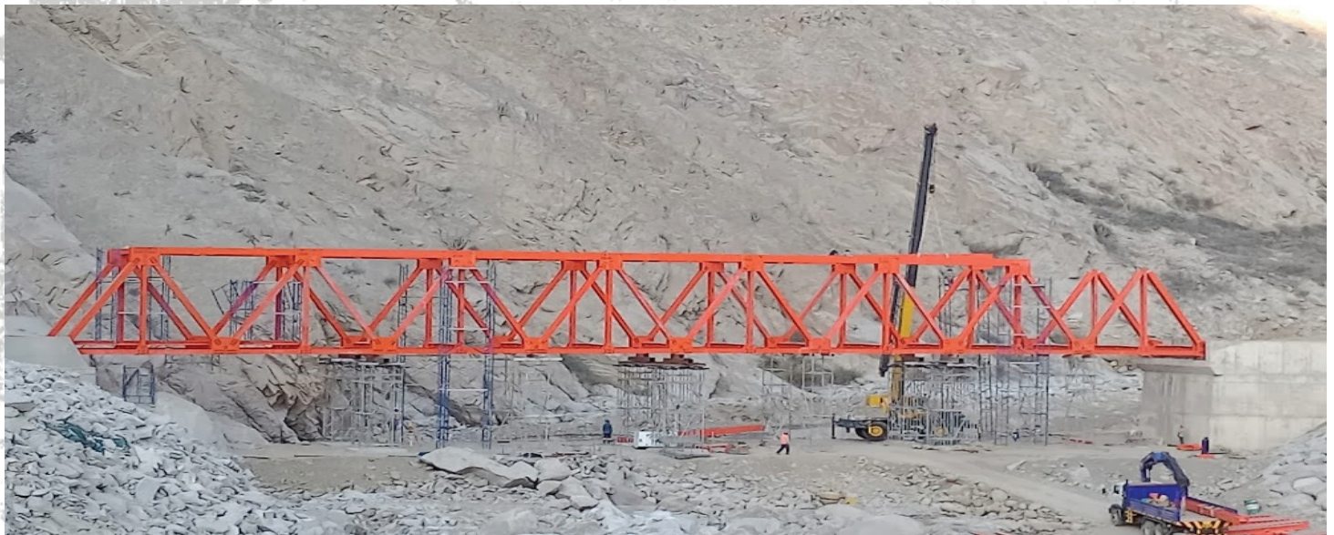
Armado del Puente Ramadillas 2021
