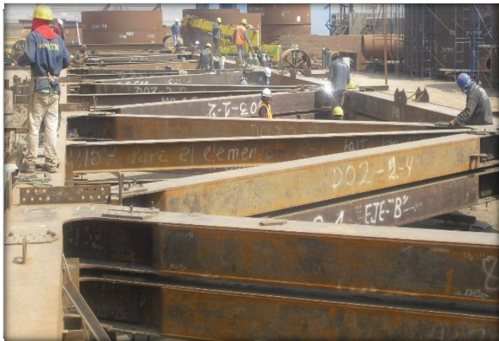
Construcción de Puente Las Monjas para transporte público. Empresa Fiansa, Huachipa - Lima.
