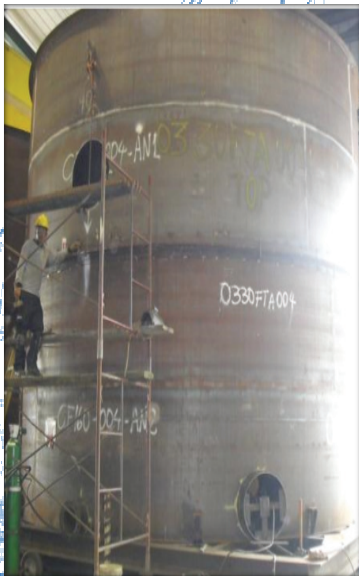
Fabricación y montaje de TK Cajamarquilla - Flsmith.
