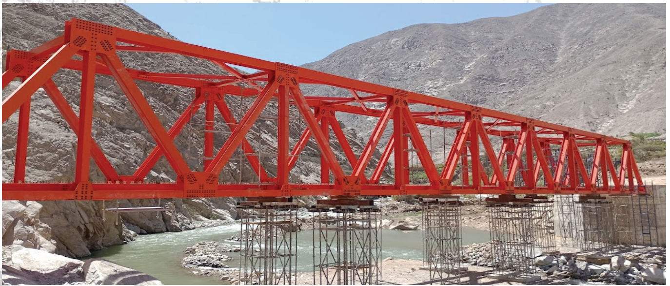
Pre-montaje del Puente Ramadillas Huaytará Huancavelica 2021
