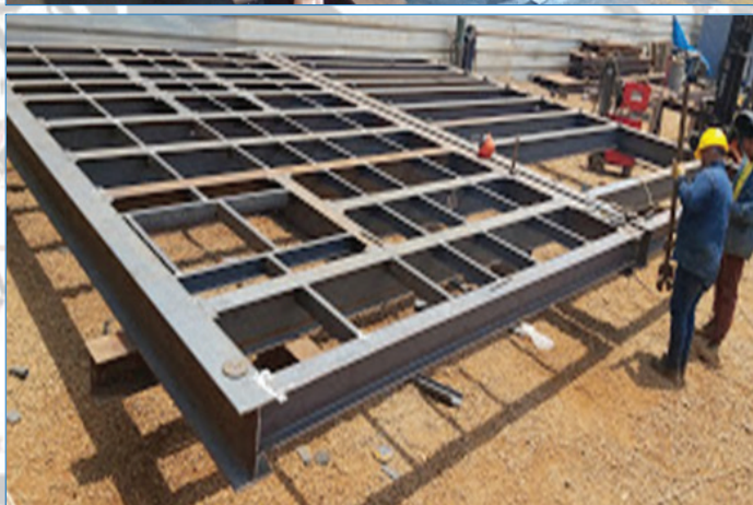
Diseño de ingeniería y fabricación de Skid para transformadores Eléctricos Ecol Electric Perú y WEG Proyecto Quellaveco
